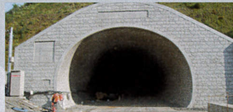
新風吹 トンネル工事
