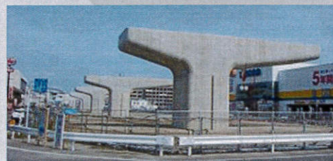
497号拾六町 高架下部工事
