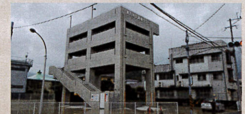
南方地区 津波避難タワー
