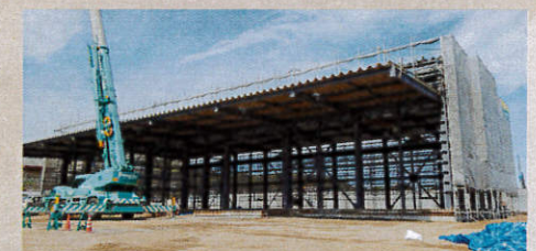
物流センター 新設工事
